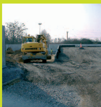
Réalisation d'un remblai de quai
