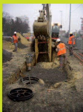
Remblai de tranchée réalisée sous le Tramway
