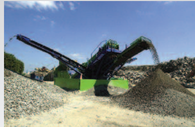
Les blocs de béton sont concassés, déferrillés et criblés pour en faire des matériaux de différentes granulométries.
