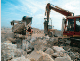
Les blocs de déconstruction de béton issus de génie civil sont réceptionnés par YPREMA.
