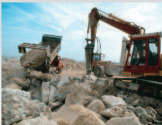
Les blocs de déconstruction de couches de chaussée mixtes (enrobés + assises, bordures de trottoirs...) sont réceptionnés et triés.
