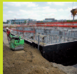
Compactage de la Grave Primaire utilisée en remblaiement
