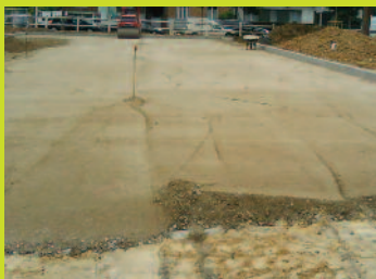
Réalisation d'une structure de voirie légère en Grave Concassée Industrielle
