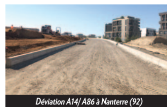
Déviation A14/ A86 à Nanterre (92)
