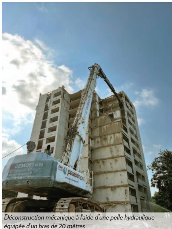
Déconstruction mécanique à l'aide d'une pelle hydraulique équipée d'un bras de 20 mètres
